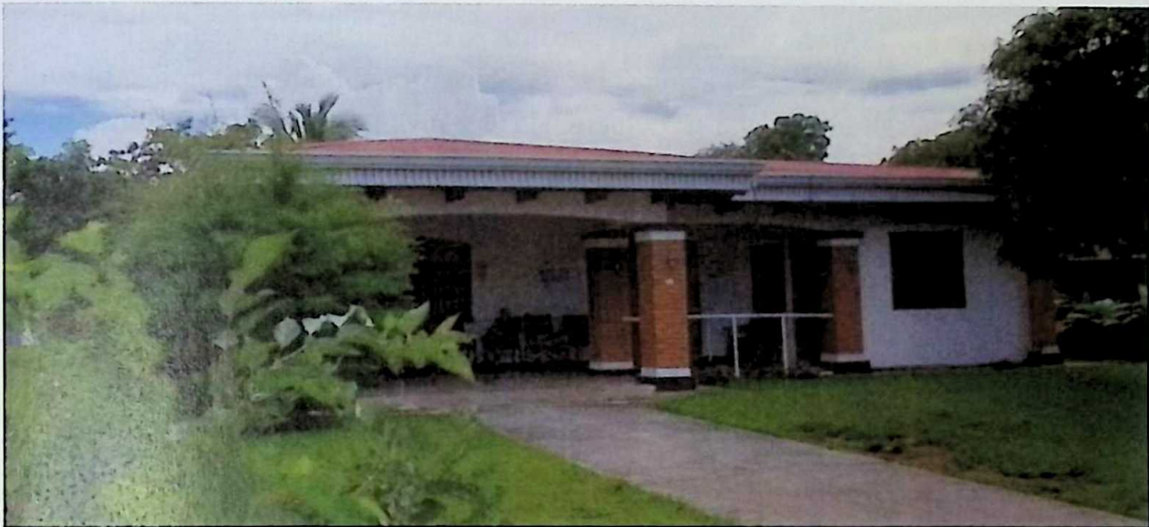
Imagen 1. Estructura del hogar de Ancianos Santa Clara Home Care
