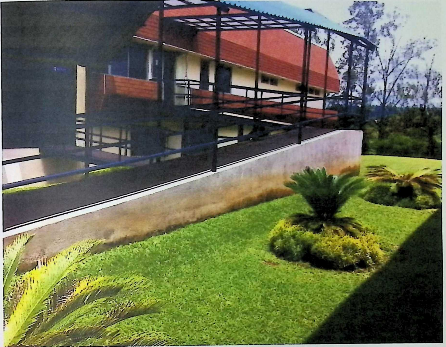
Anexo (12) Rampa que lleva al segundo nivel de la Biblioteca
