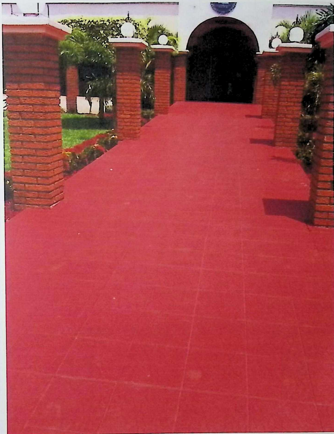
Anexo (18) Rampa que lleva a Oficinas Centrales
